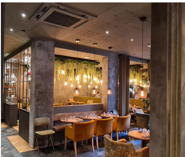
Installateur LC Climatisation - Crédit Photo JAB
